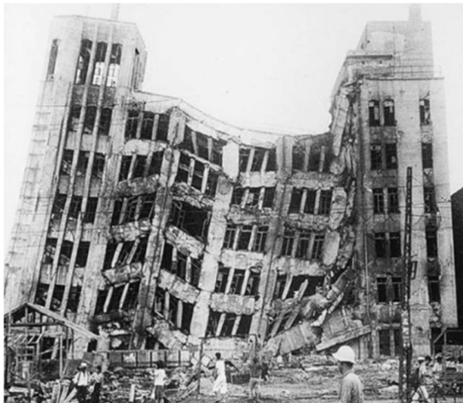
福井地震による内外ビル(RC造6階建て)の被害
