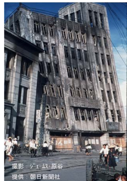
福井地震による内外ビル(RC造6階建て)の被害
