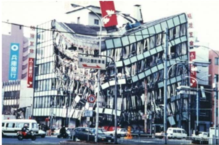
RC造建物の被害
