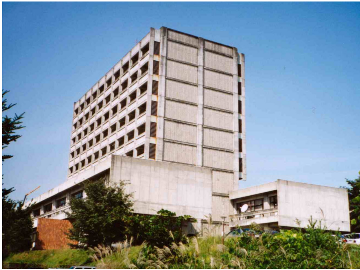
東北大学工学部建設系建物 (SRC造、9階建、1969～) 1978年宮城県沖地震で被災、妻壁せん断きれつ
